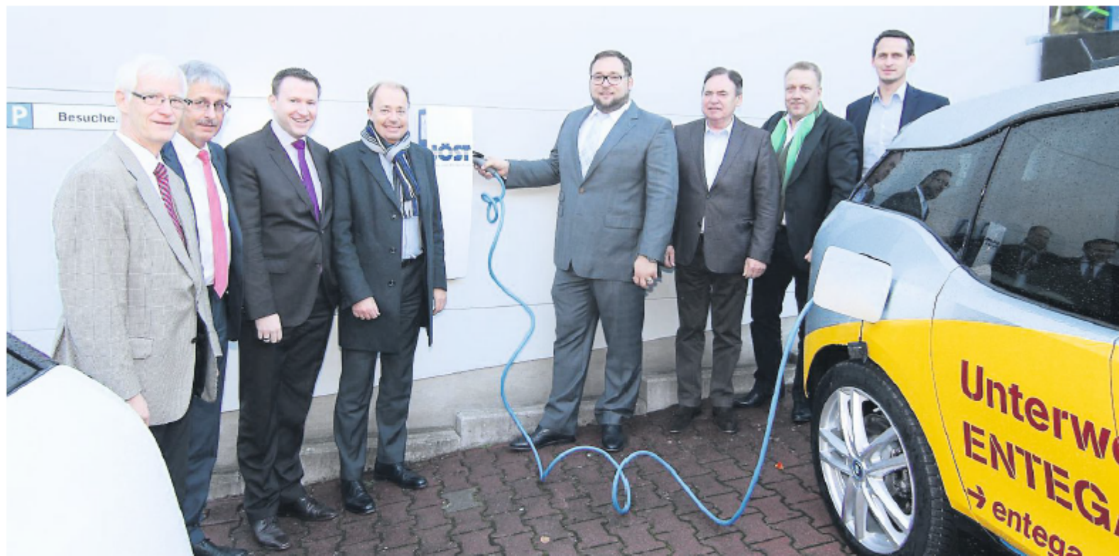
In der Gemeinde Wald-Michelbach können Autofahrer jetzt Strom tanken: Am Firmensitz von Jöst-abrasives in Affolterbach weihten Gemeinde sowie die Firmen Entega und Jöst-abrasives die neue Elektro-Tankstelle ein. Sie ist öffentlich zugänglich und hat zwei Ladepunkte mit einer Leistung von jeweils 22 Kilowatt. Damit ist auch die Schnellladung möglich. BILD: ENTEGA
