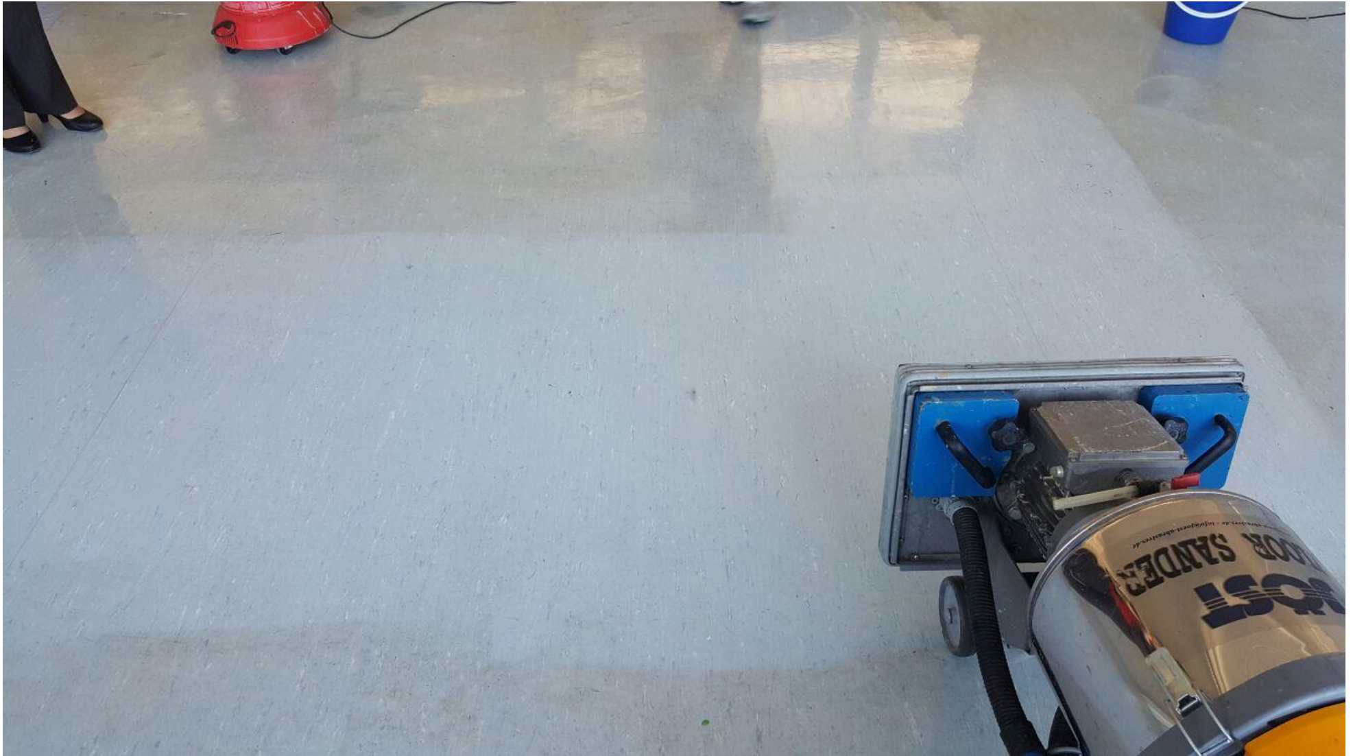
PVC gereinigt mit Floor Sander und SG 240 nass
