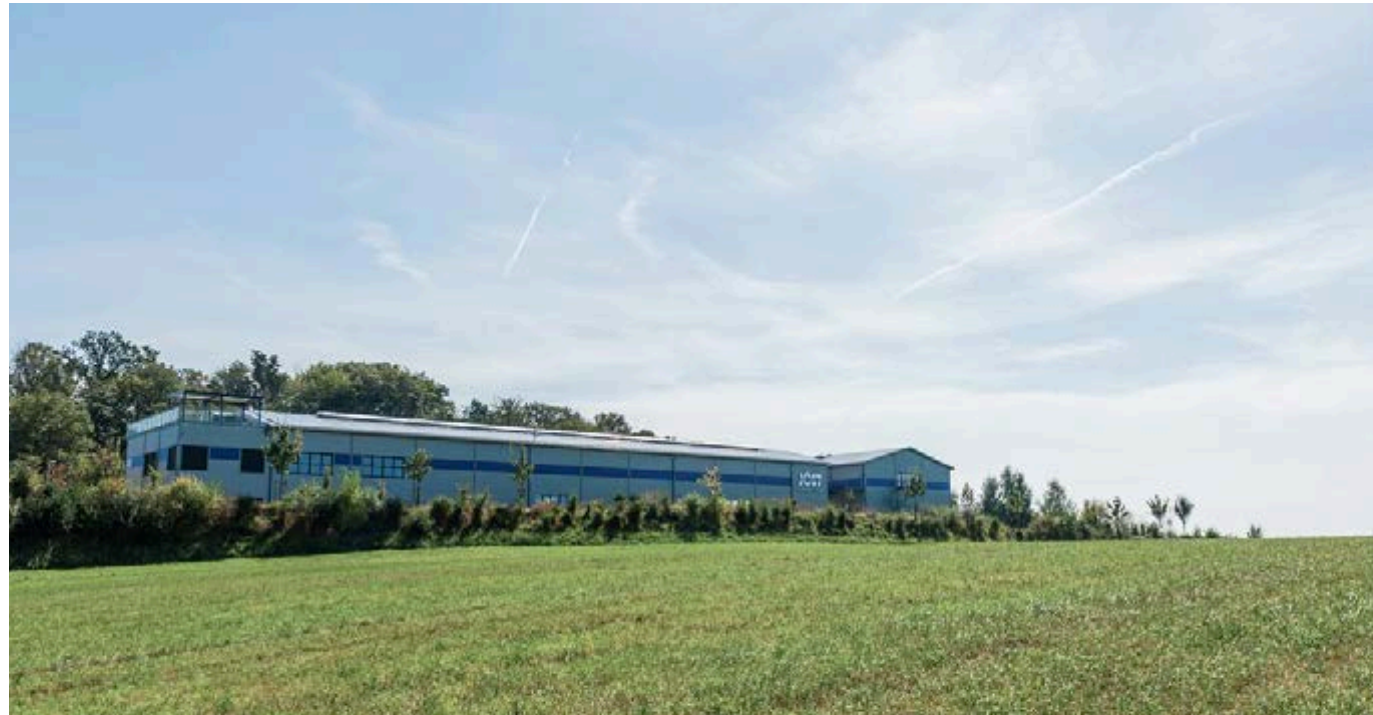
Jöst Versand- und Logistikzentrum, Abtsteinach.
