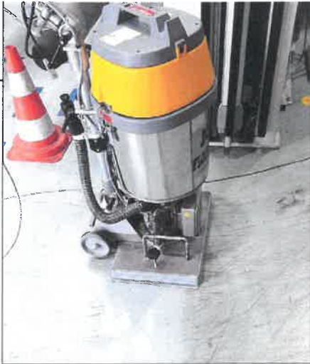
Ein mit Epoxidharz beschichteter Industrieboden wird wieder wie neu. Selbst Reifenspuren von Staplern etc. entfernt der mit SG-600-Pads bestückte Floor Sander rückstandslos
