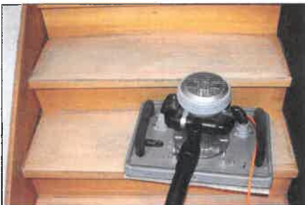
Der mit Schleifmittel bestückte Schwingschleifer Big Boy kann gut zum Sanieren von Treppenstufen eingesetzt werden.
